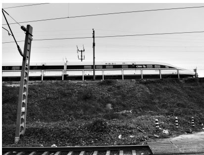
铁路沿线个别地段垃圾散布。
