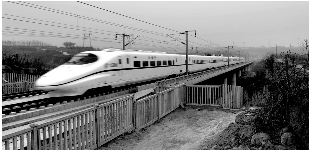
西三环与郑少高速入口处的郑西高铁附近有施工现场,绿化有待改善。
