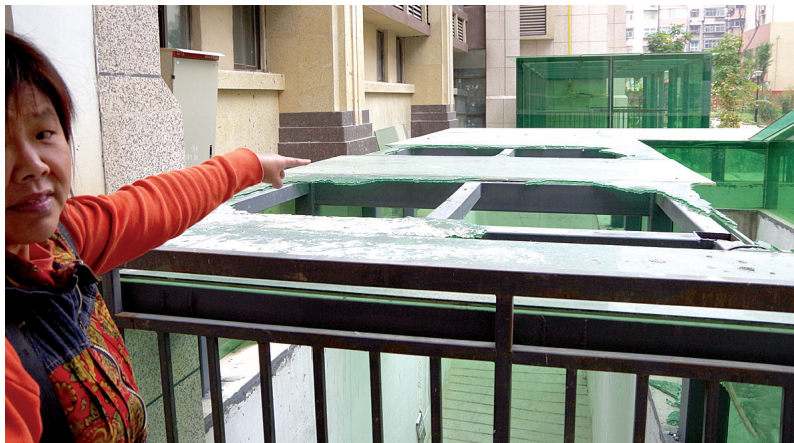
7号楼楼前地下空间使用的透光玻璃也因高空坠物被砸出多个窟窿。
