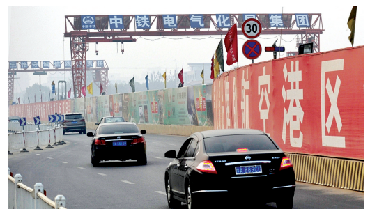
航空港区在各种建设工地的繁忙中逐渐清晰起来。
