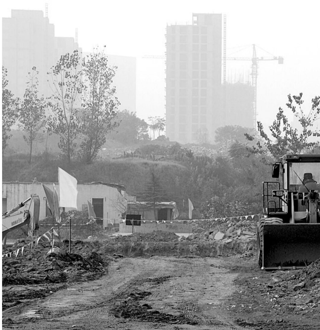
龙子湖区域的一处建筑工地
