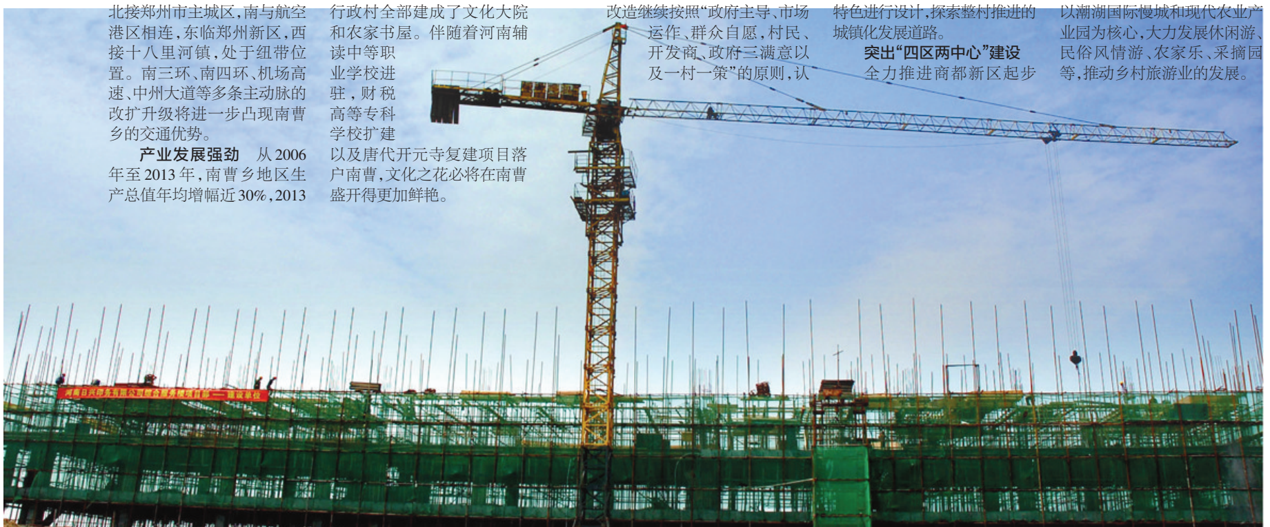
正在建设的工地
