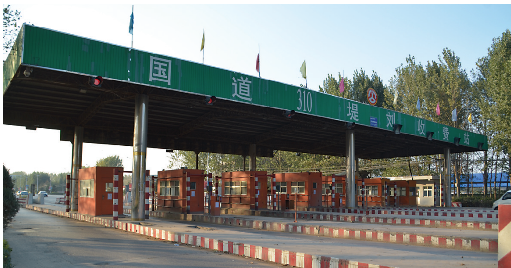
已经拆除栏杆的堤刘收费站
