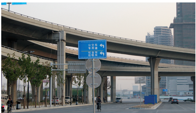
公交车辆,出租车辆需由站南路统一入站,社会车辆进入站区必须到停车场内接送、等候客人。
