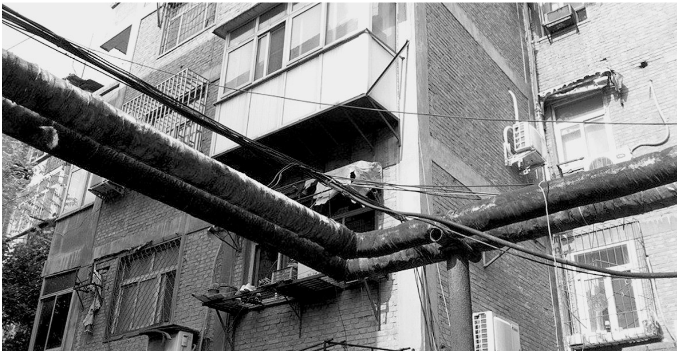
老旧小区内管网老化
