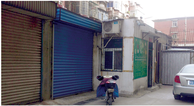
缺乏生活用水导致无法运行热力站
