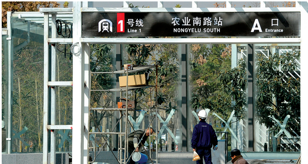
农业南路地铁站的出入口施工接近尾声
