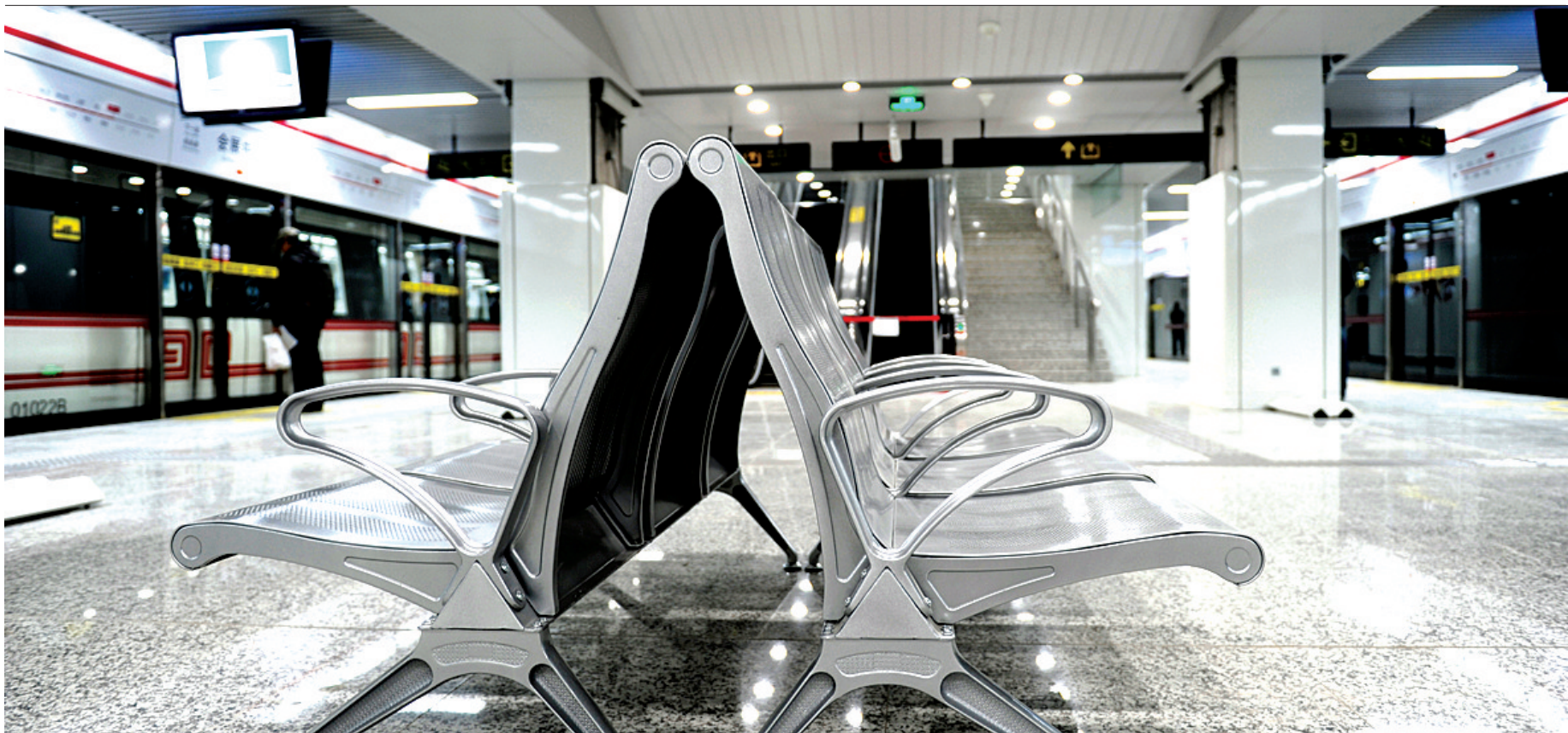
昨天中午,地铁会展中心站负二层,几条候车座椅已经安装到位,座椅为金属材质,既结实耐用又利于打扫。 郑州晚报记者 马健 图
