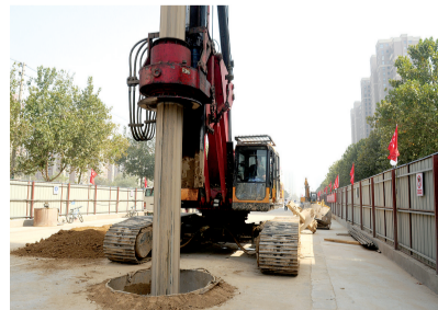
正在施工的陇海路高架快速路
