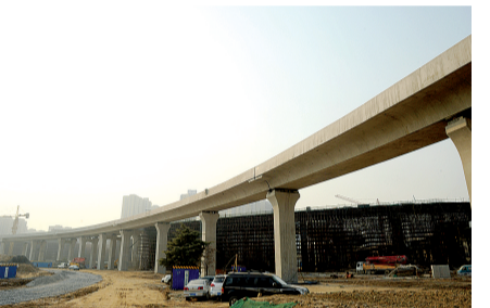
正在施工的北三环中州大道立交桥
