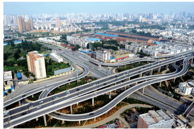
农业路京广快速路立交桥
