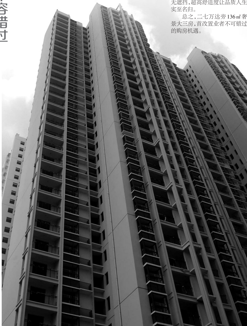
正在建设的万千世纪城实景
