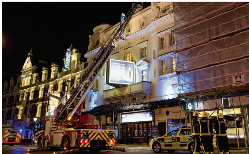
12月19日,救援人员在英国伦敦发生坍塌事故的阿波罗剧院工作。
