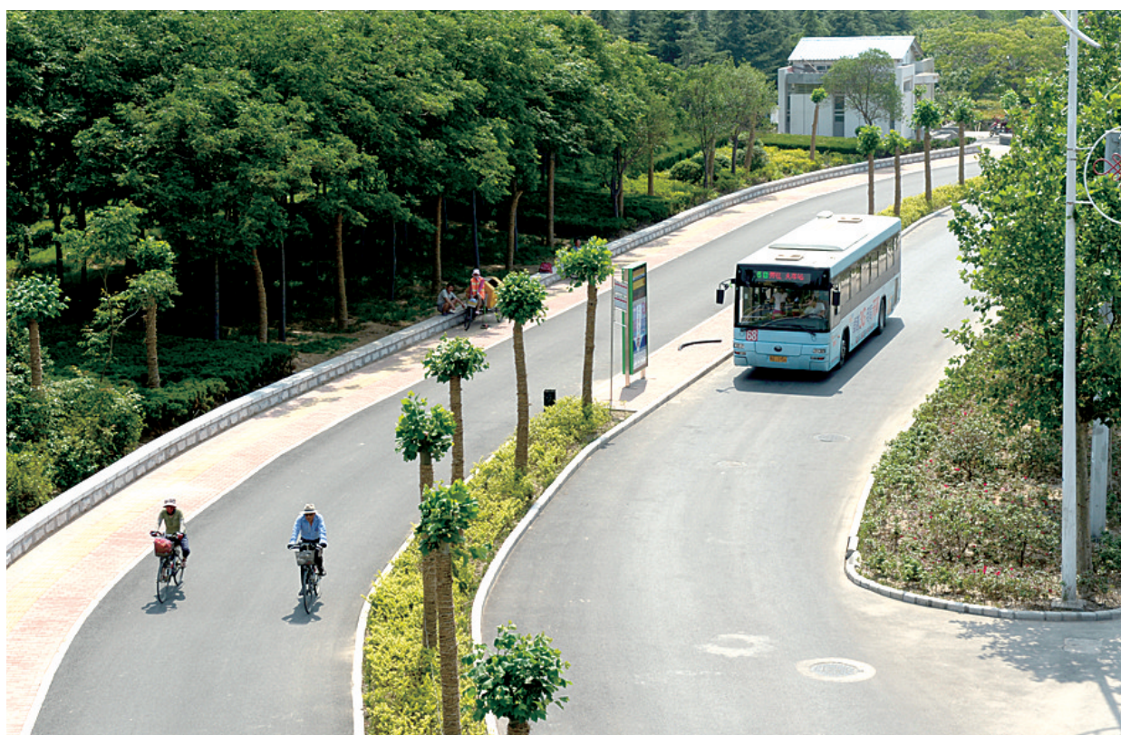
公交港湾方便了市民乘车,提高了道路通行能力。记者 唐强 图
