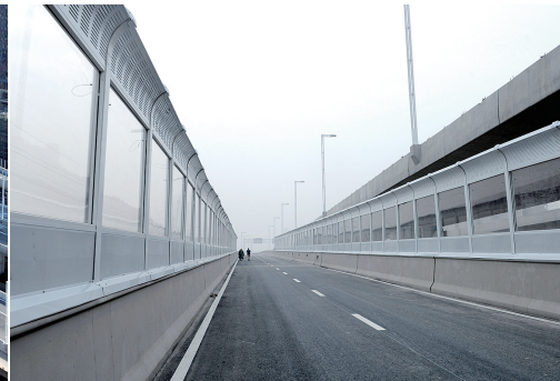
12月下旬,北三环文化路立交桥基本设施安装到位。昨日,华北水院二层下口处,已经装设好隔音屏障。
