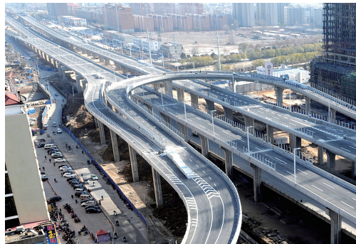
12月下旬,北三环文化路立交桥基本设施安装到位。昨日,华北水院二层下口处,已经装设好隔音屏障。
