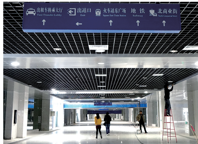
郑州火车站地铁站地下换乘大厅仍然在施工,将来这里将连通东西广场,并将开设商业街。 郑州晚报记者 马健 图
