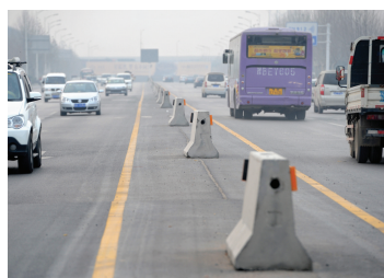
昨日下午,东四环向东的郑开大道上,路中间设置的过渡隔离墩没有串联。
