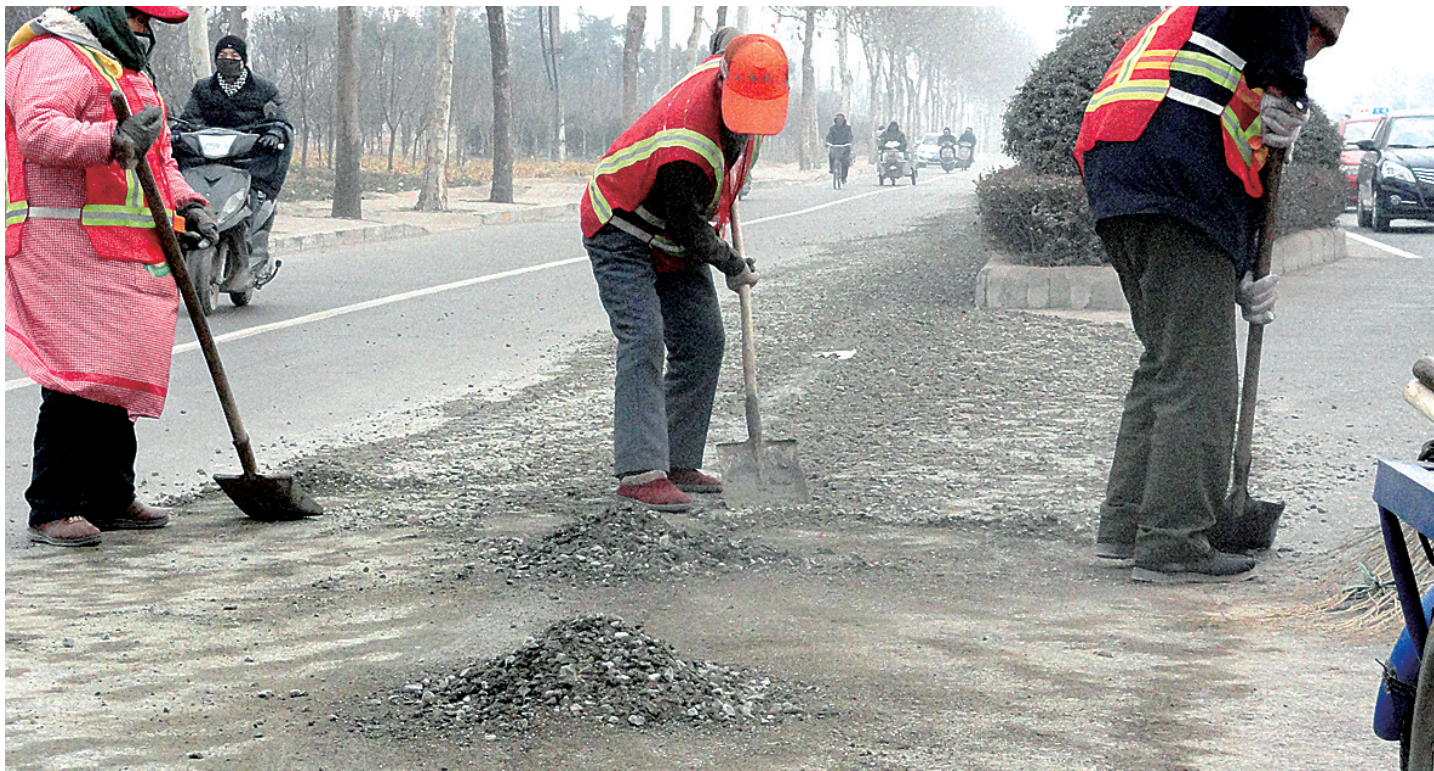
环卫工正在清扫路中混凝土。
