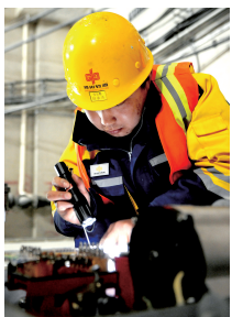
巡检人员正在对轨道信号转辙机零件进行更换，转辙机是轨道通行的保障。
