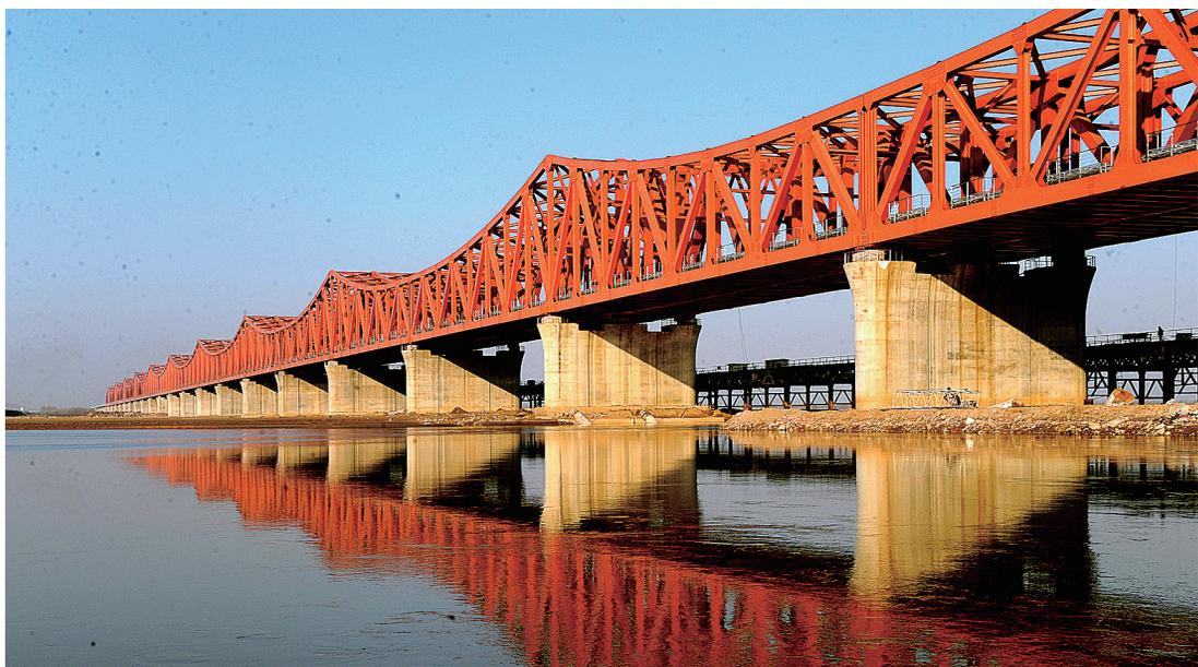
由中铁大桥局建设的河南郑州至焦作铁路客运专线暨改建京广铁路跨越黄河特大型铁路桥工程日前主体工程完工。该线铁路桥是郑州市境内规划的第六座跨黄河大桥,设计全长9633米,采用四线铁路技术标准,也是黄河上第一座四线铁路桥梁,大桥计划于2014年4月通车。
