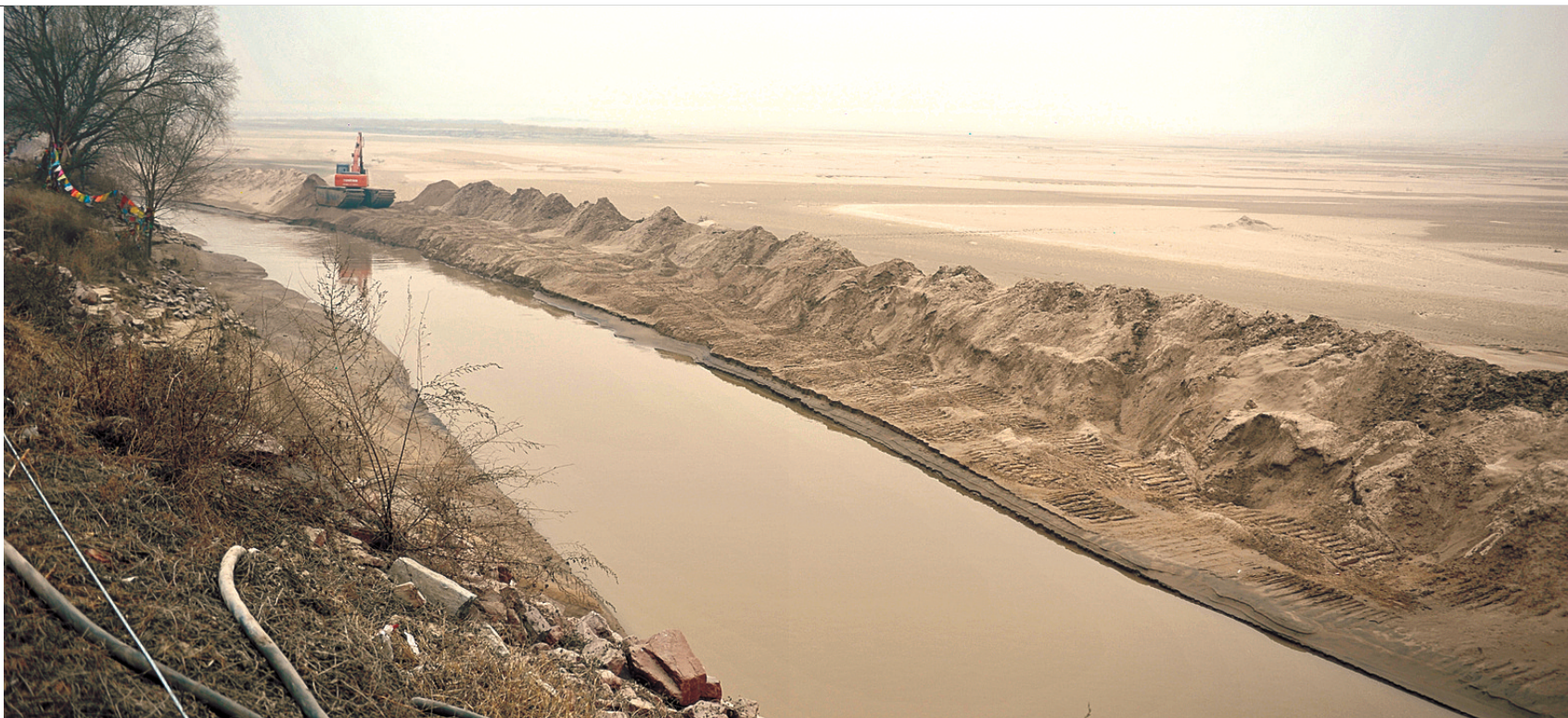
黄河挖出的引水渠,为白庙水厂供水。
