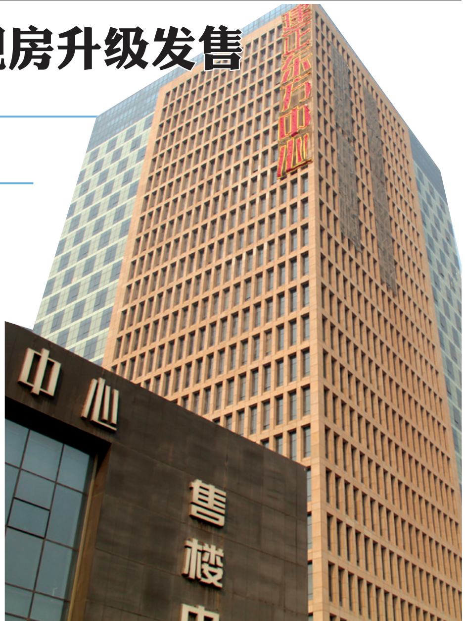
建正东方中心实景图
