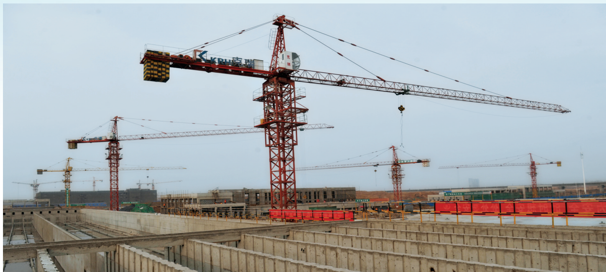
实验区第一水厂建设正酣。
