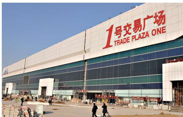
华南城施工现场
