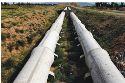
宁夏中卫市,黄河水靠电力抽取后通过这些管道被输送到各个灌区。
