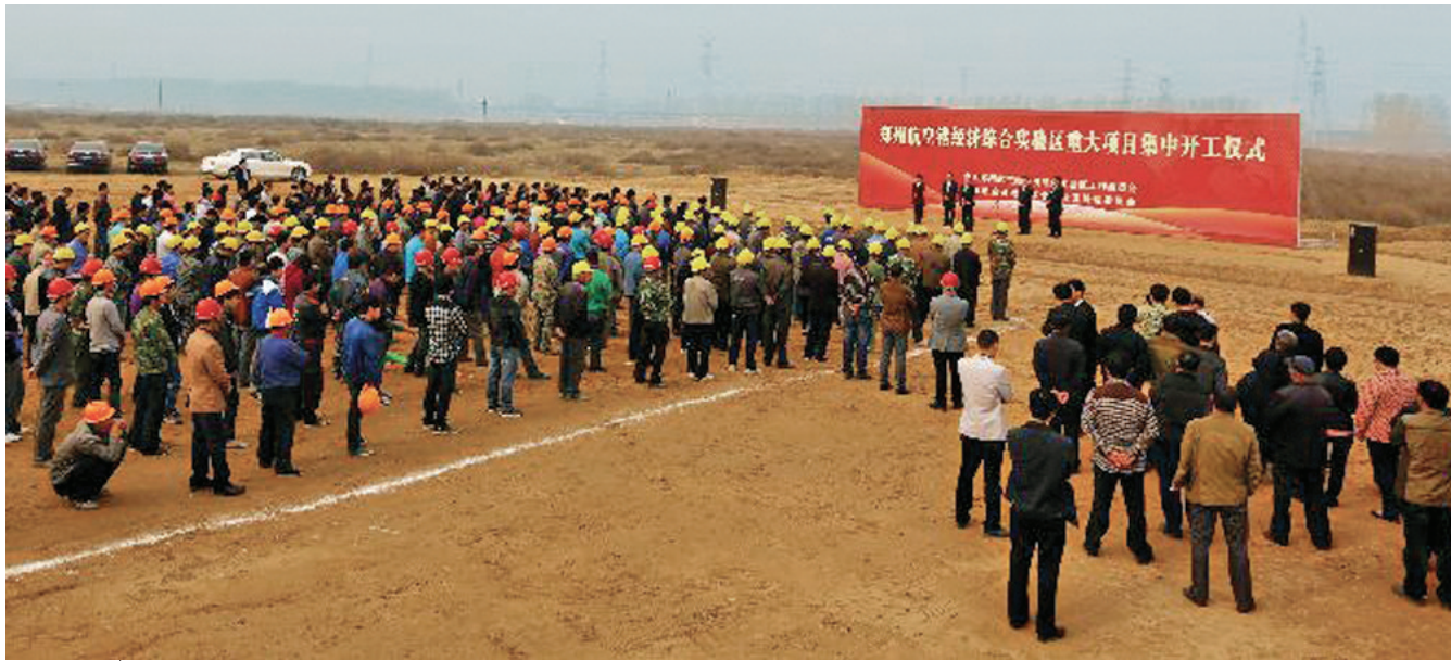
集中开工仪式现场
