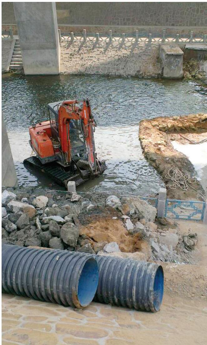
建设东路北侧破裂的污水管正在修理
