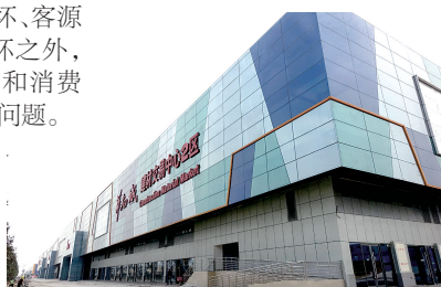
即将投入使用的华南城建材交易中心。
