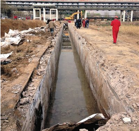
兰州威立雅水务集团的施工人员拆除被污染的4号自流沟,准备安装新管道。
