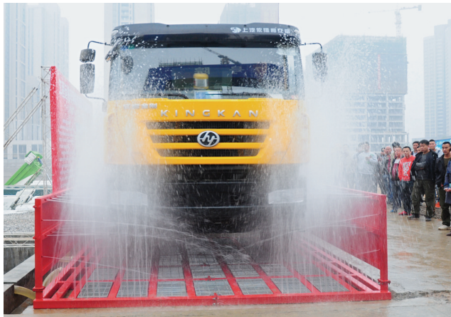
昨日下午,一台新能源渣土车驶过高山路升龙城工地出口的冲洗区。
