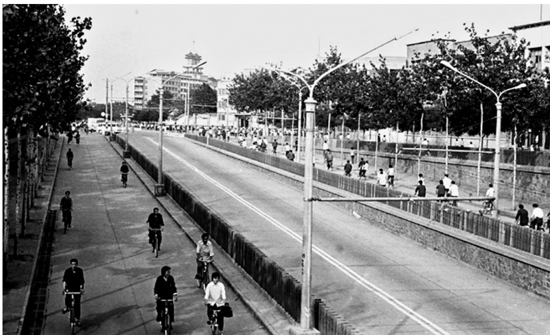
中原路地下通道
