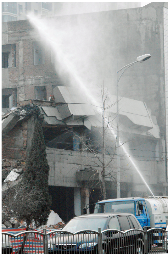
作业工人采取洒水压尘
