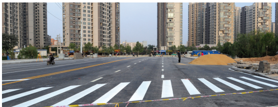
连接徐寨路与文劳路之间的东风渠桥已经画好了分道白线。
