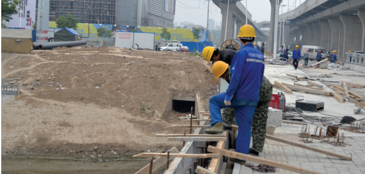
昨日,北环路东风渠桥上,工人正在安装护栏
