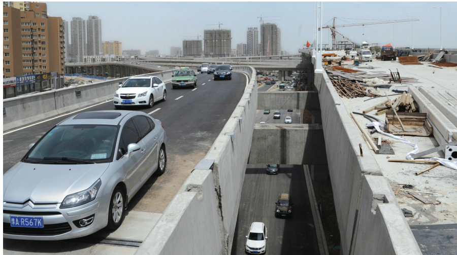
昨日中午,中州大道北三环口,桥上仍在施工。
