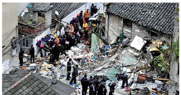
4日凌晨,上海虹口区发生一老式民宅倒塌事故
