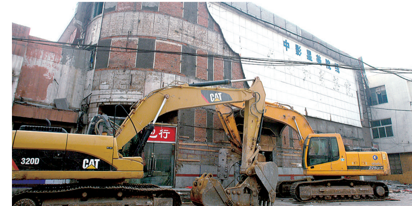
2011年2月,正在拆除的东方红影剧院。
