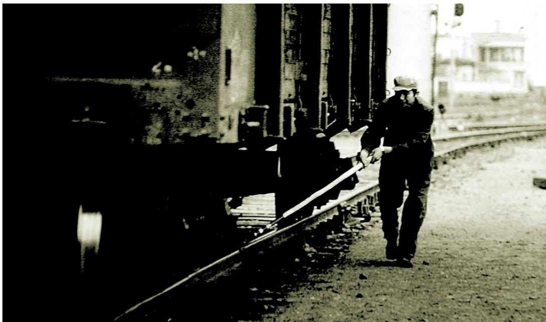
1986年,制动员手拿铁叉子戳着铁鞋放在滚动的车轮下。
