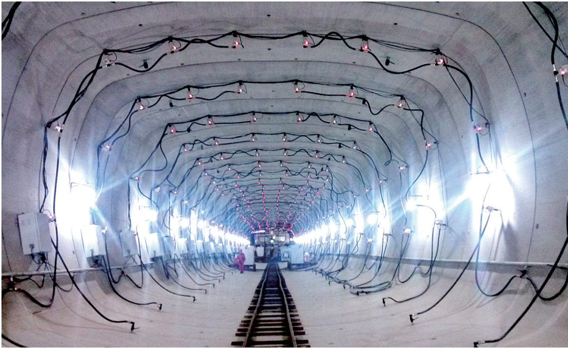
纬四路A3号车道大顶管顺利贯通隧道内情况
