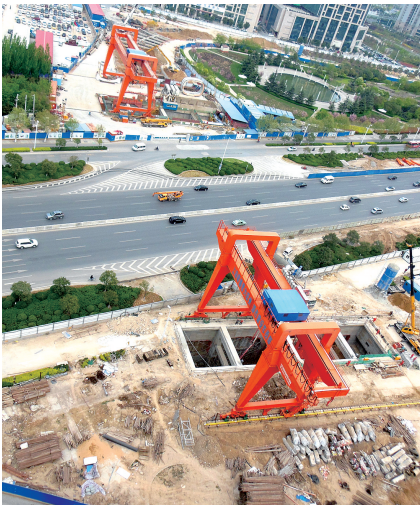
纬四路至商务西三街施工情况俯视图
