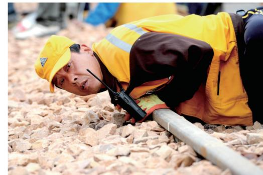
新老钢轨对接成功后,技术员趴在轨上目测钢轨高低是否一致。
