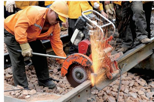
新架钢轨对接时,工人切长出的钢轨。
