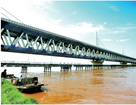
郑新黄河铁路大桥创造多个“世界第一”
