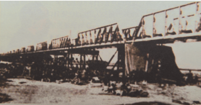
郑州普河铁路大桥因设计问题,不堪重负,坍塌严重
