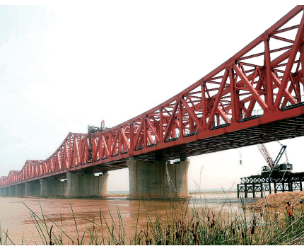
郑焦城际铁路黄河大桥已经正式通车
