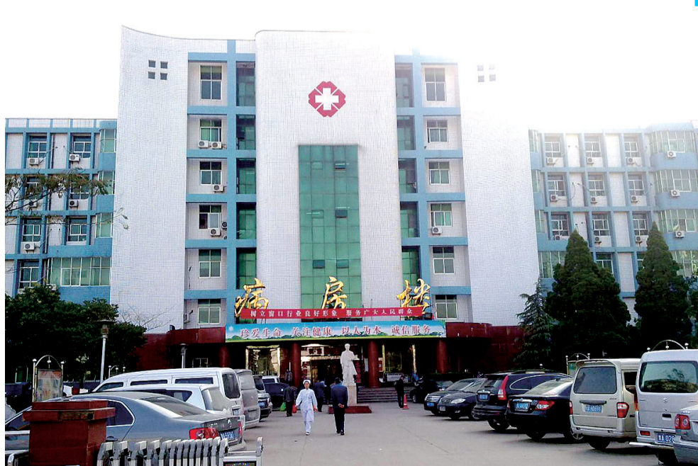
中牟县人民医院老区医院病房楼
