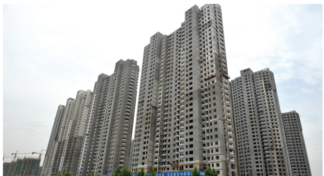
潮河办事处瑞锦安置小区建设现场图
