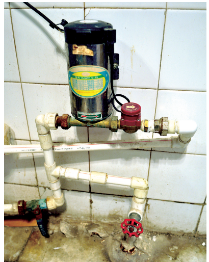
为了吃水,把抽水机安装在水管上。
