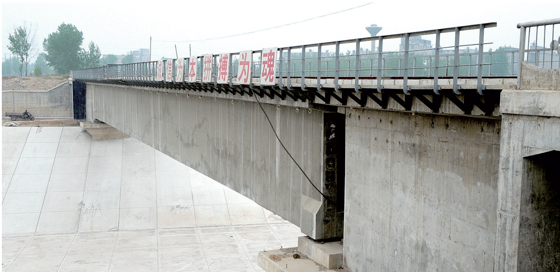
宝丰县境内,南水北调干渠邂逅了繁忙的焦柳铁路
