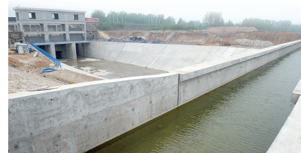
宝丰县境内南水北调干渠施工现场
