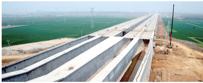
沙河渡槽施工现场
