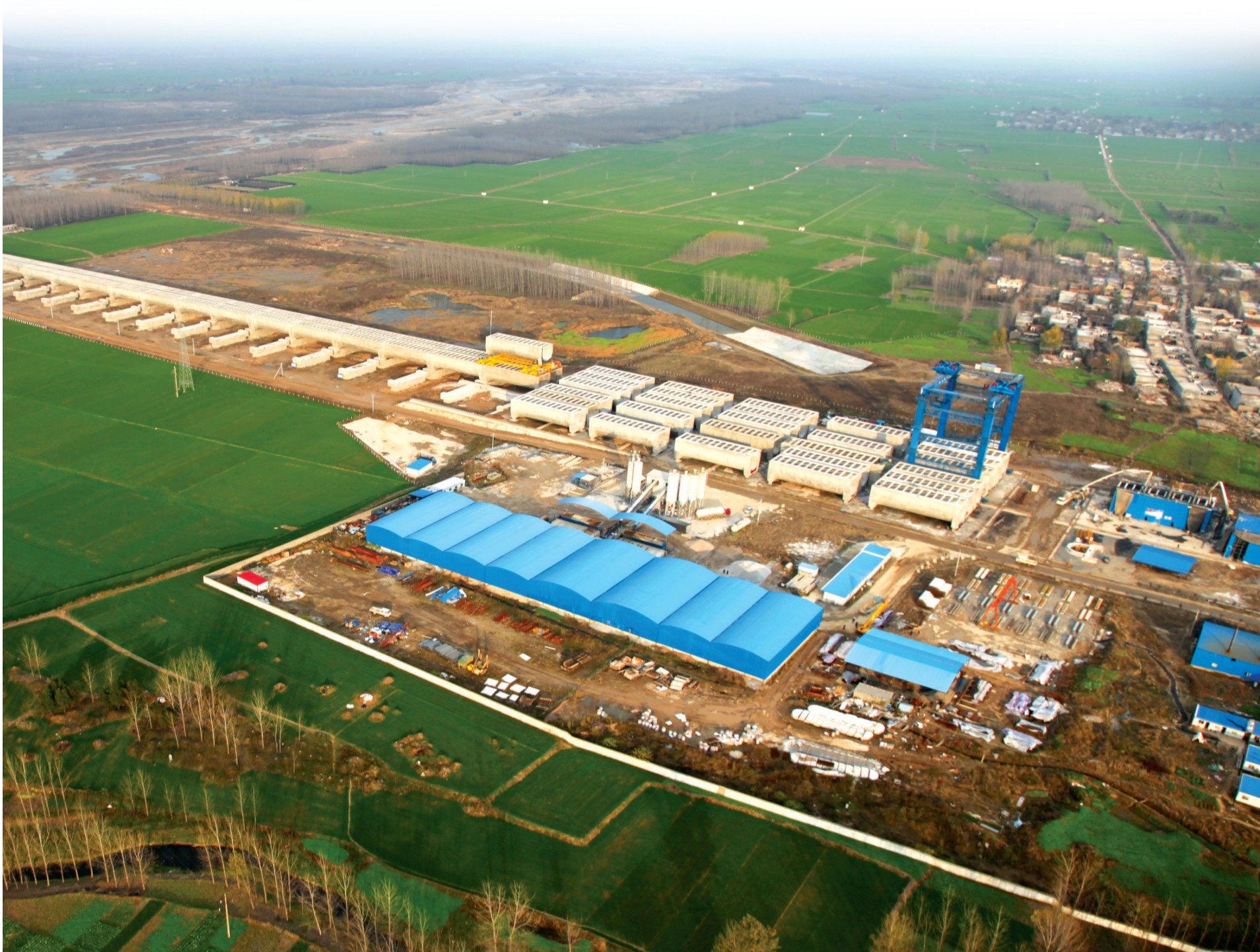
沙河渡槽航拍图。沙河渡槽单跨跨度30米、槽高8.3~9.2米、槽宽9.2米
