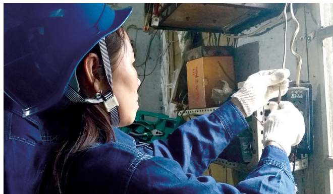
三八雷锋班在孤寡老人家检查线路老化问题。
