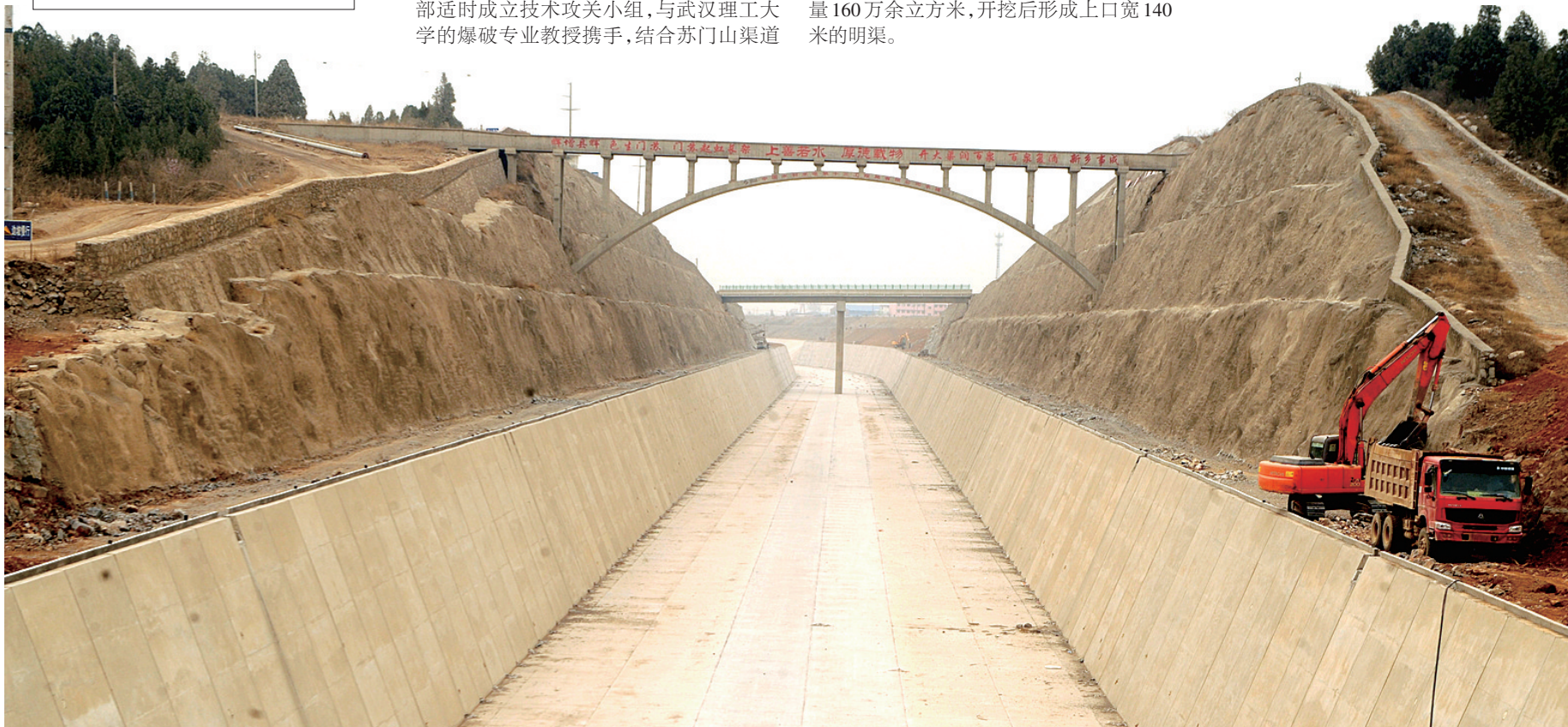
苏门山段总干渠需贯穿苏门山尾部
