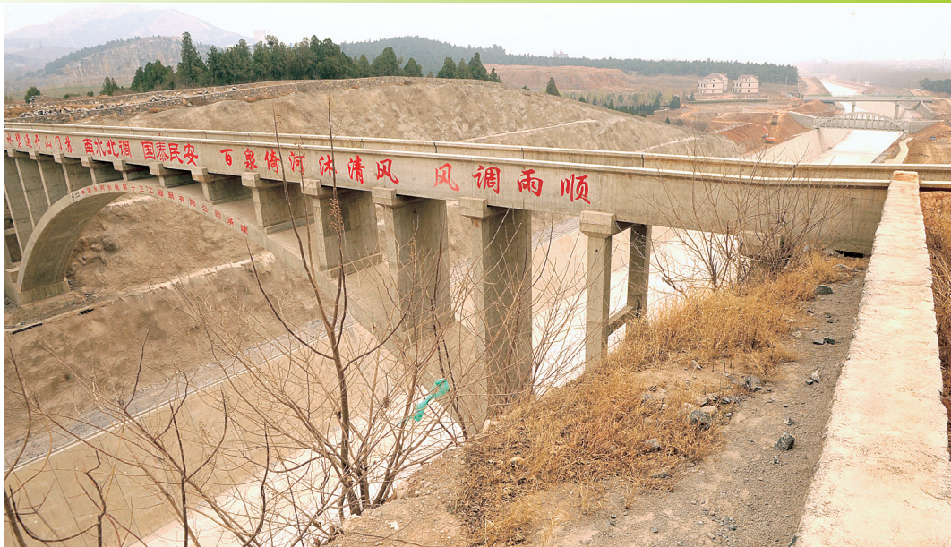
南水北调辉县市工程现场,该段工程复杂程度超出想象
