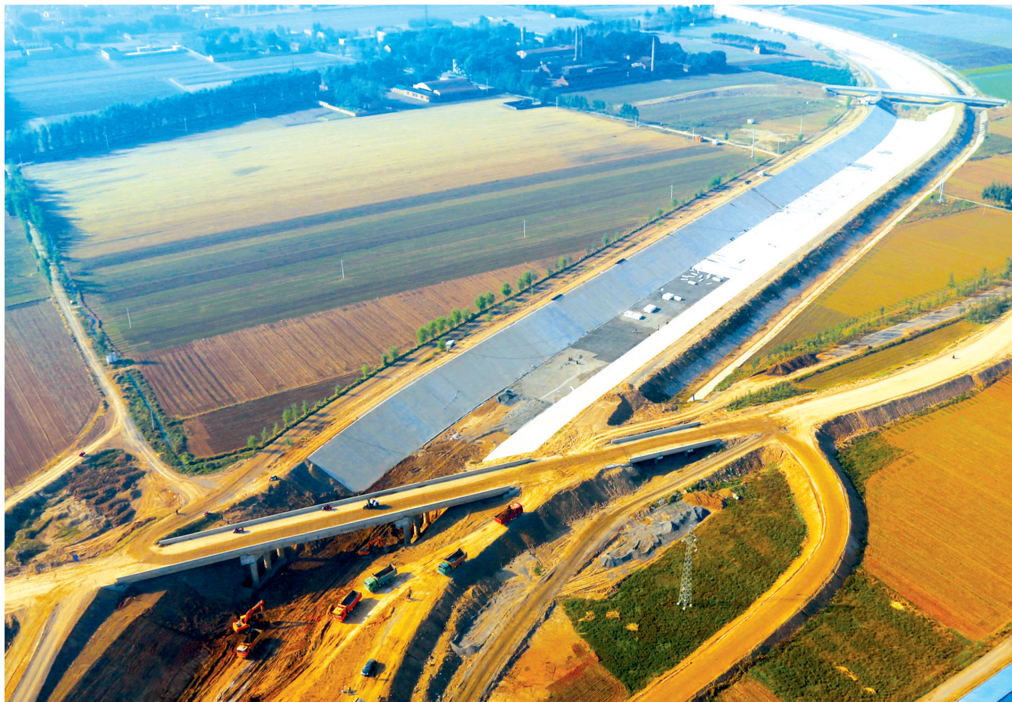
南水北调中线工程焦作段是唯一穿越市区，高出地面数米的“地上悬河”。
