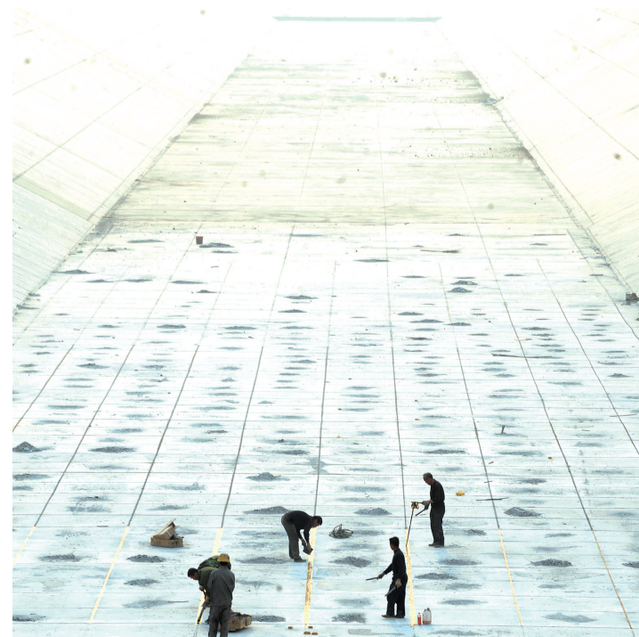
一天到晚有500万吨到700万吨水通过焦作市区，施工技术和质量控制极为严格。
